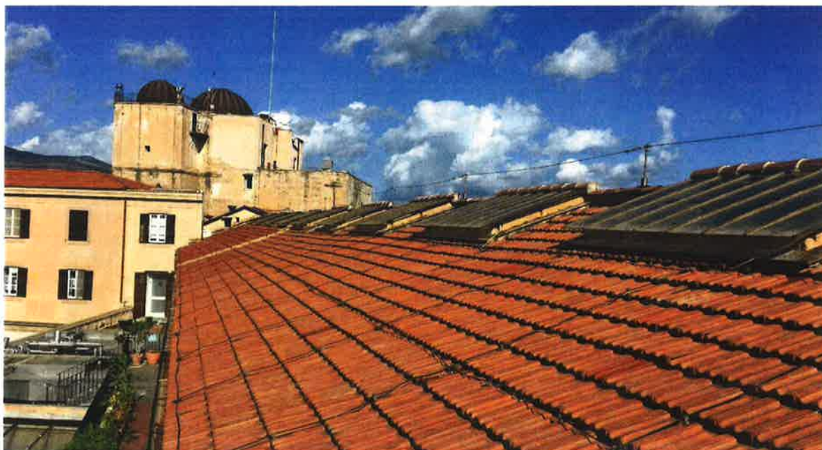
Figura 27 - Estradosso della copertura Uffici ultimo piano Nord
