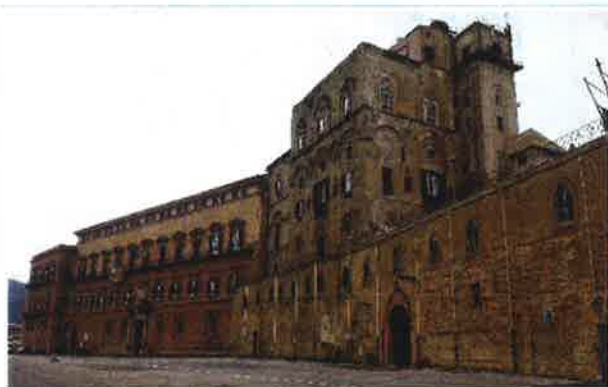
Figura 3 - Involucro esterno prospetto nord-est
