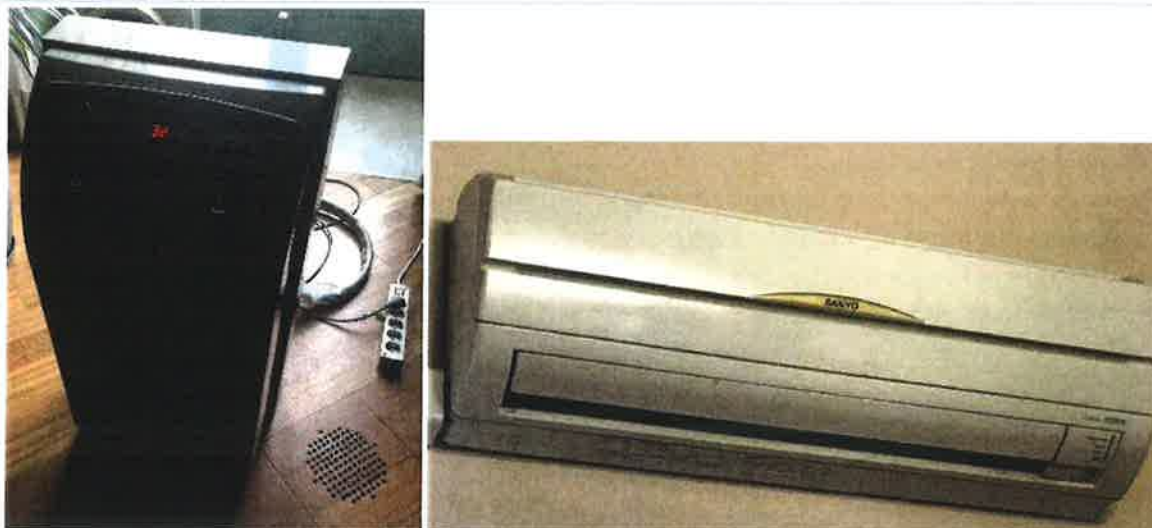
Figura 11 – Tipologie di terminali di climatizzazione
