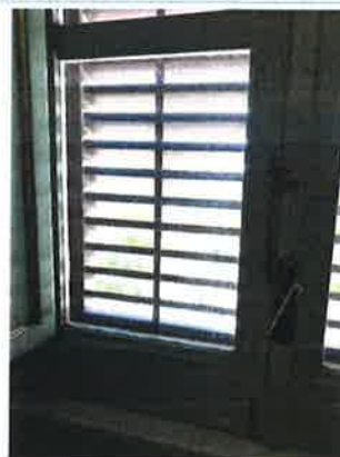
Figura 8 - Involucro trasparente (tipologia finestre in legno con vetro singolo)
