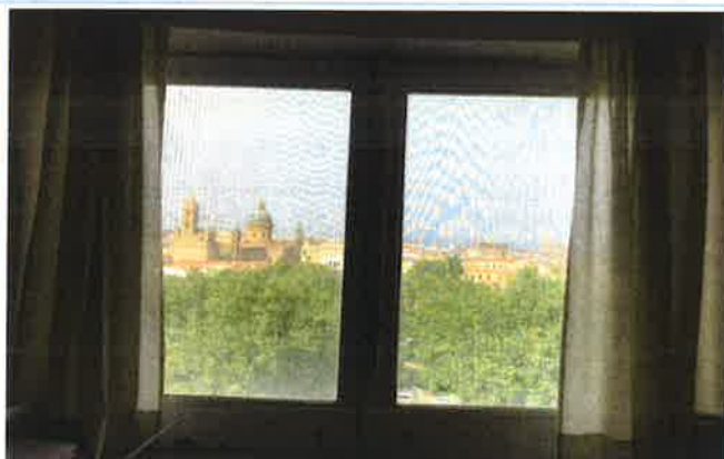
Figura 7 - Involucro trasparente (tipologia finestre in legno con vetro singolo)
