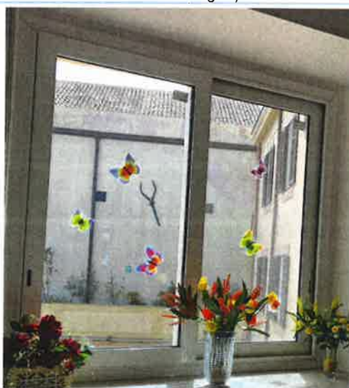
Figura 10 - Involucro trasparente (tipologia finestre in alluminio con vetro doppio)
