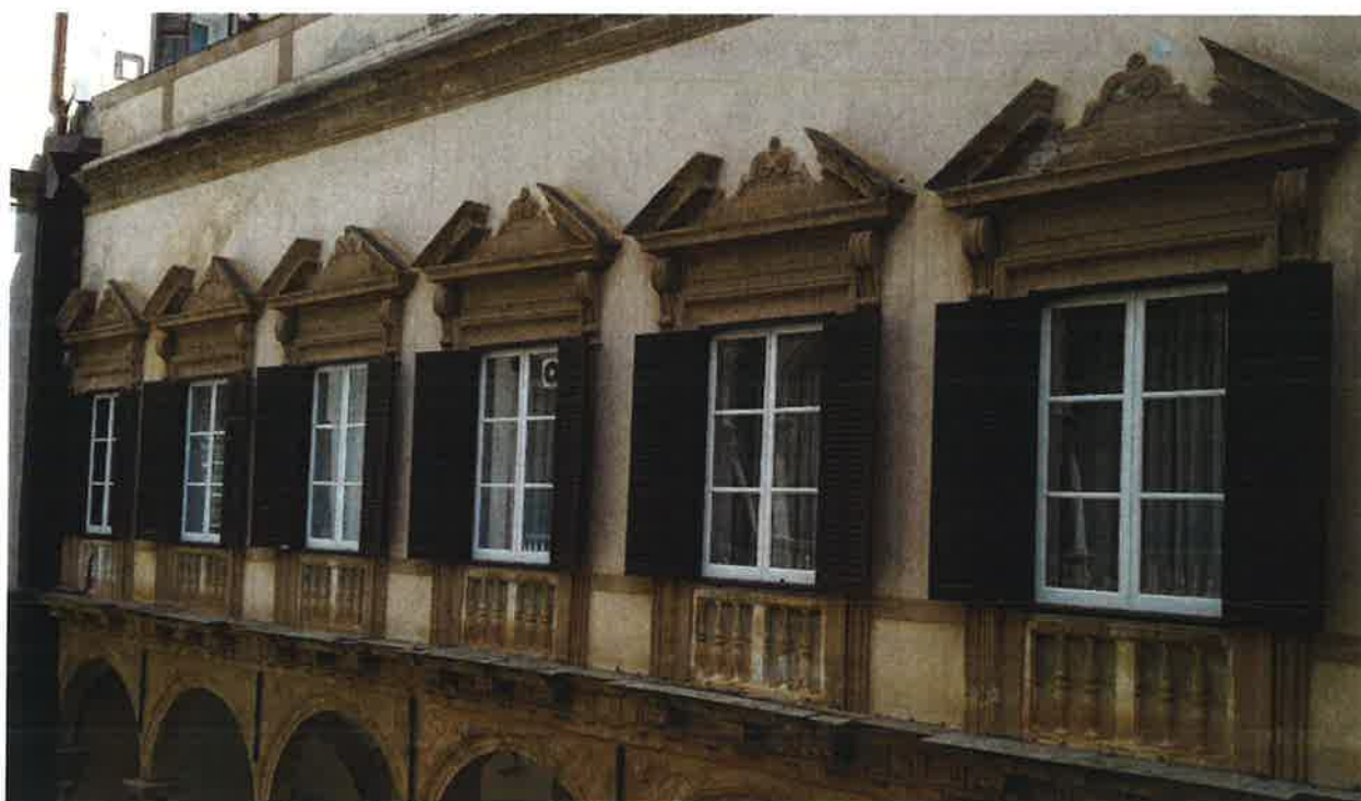
Figura 31 - Finestre in legno vetro singolo prospicienti il cortile della fontana
