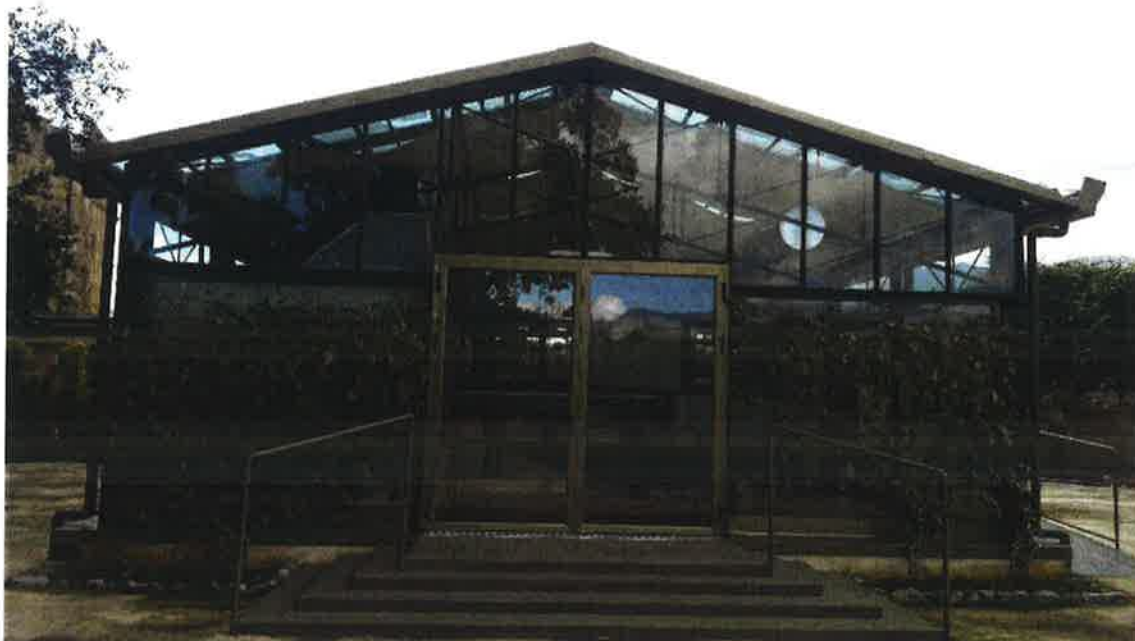
Figura 37 - Vista esterna caffetteria
