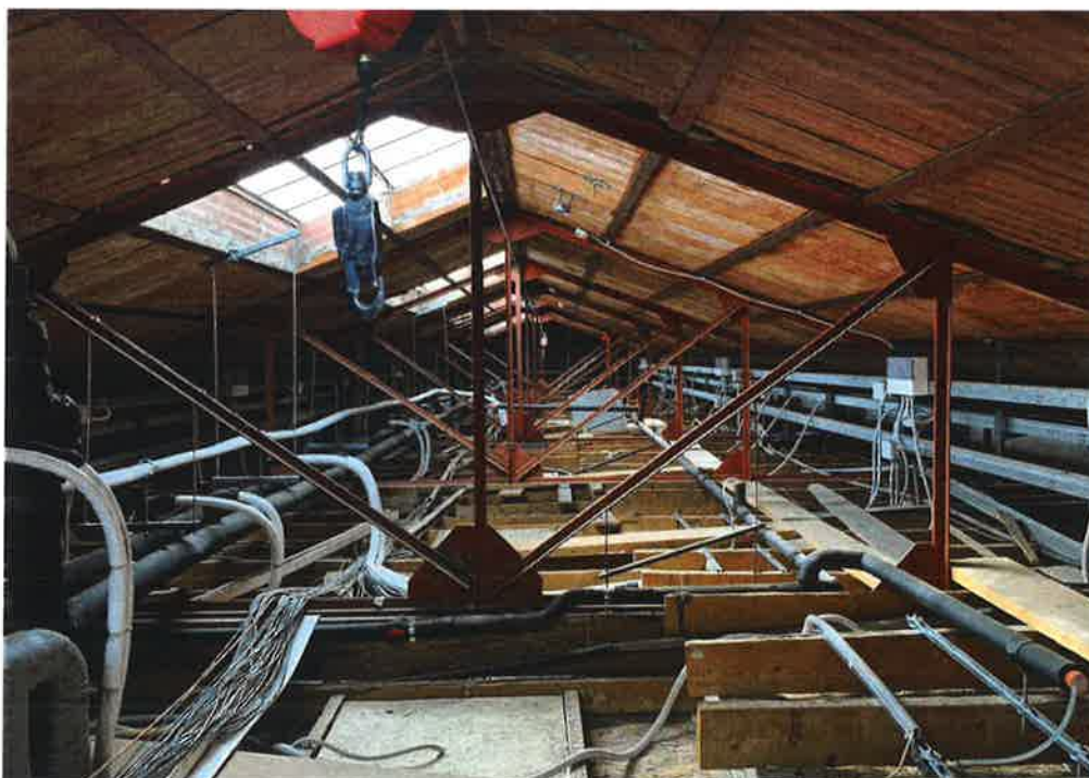
Figura 28 – Intradosso della copertura Uffici ultimo piano Nord
